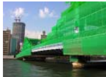
橋りょうの補修
