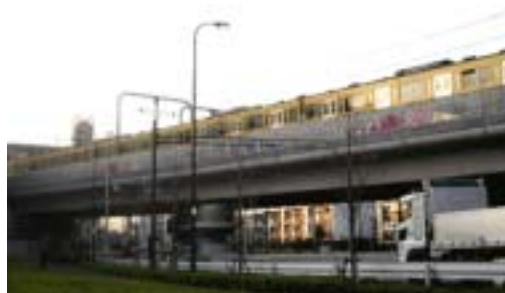
鉄道の連続立体交差化事業
