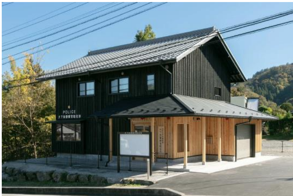
阿南警察署大下条駐在所建設工事
