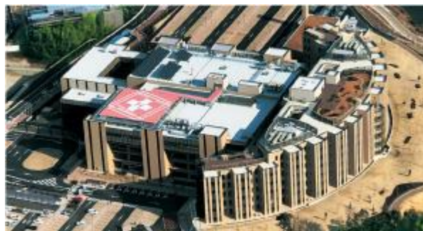
新奈良県総合医療センター
