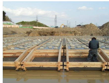
河川工事（護床工）の事例
