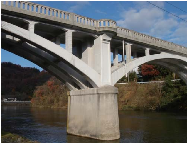
橋脚上のバルコニーとリブアーチの曲線が軽やかさを感じさせる
