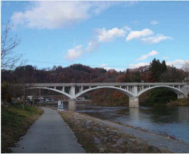
3径間連続アーチの旧最上橋。橋の後方に見えるのが楯山
