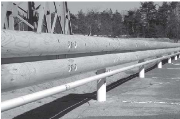
信州型木製ガードレール 1号型 ビーム：スギ半割材(φ18cm、銅板付) 2段 支柱：鋼管 4m間隔
