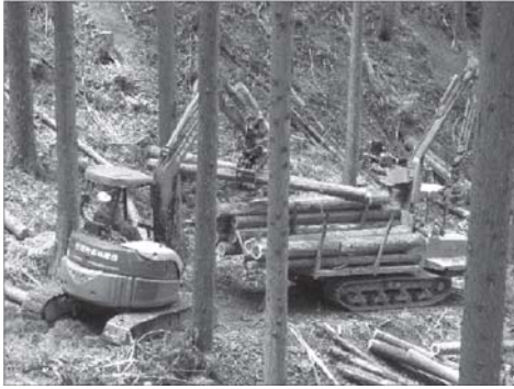
間伐材の撤出状況
