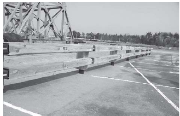
信州型木製ガードレール 2号型 ビーム：カラマツ角材(15cm角、補強丸鋼入) 2段 支柱：鋼管(カラマツ角材覆い) 2m間隔
