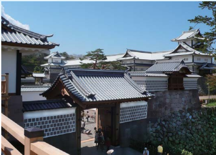
手前は、昨年4月に復元した金沢城三御門の一つで、実質的な正門「河北門」 奥は、H13年に完成した「菱櫓・五十間長屋・橋爪門続櫓」
