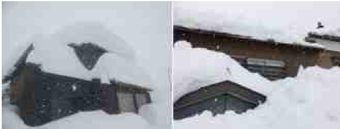
災害救助法による除雪の実施
