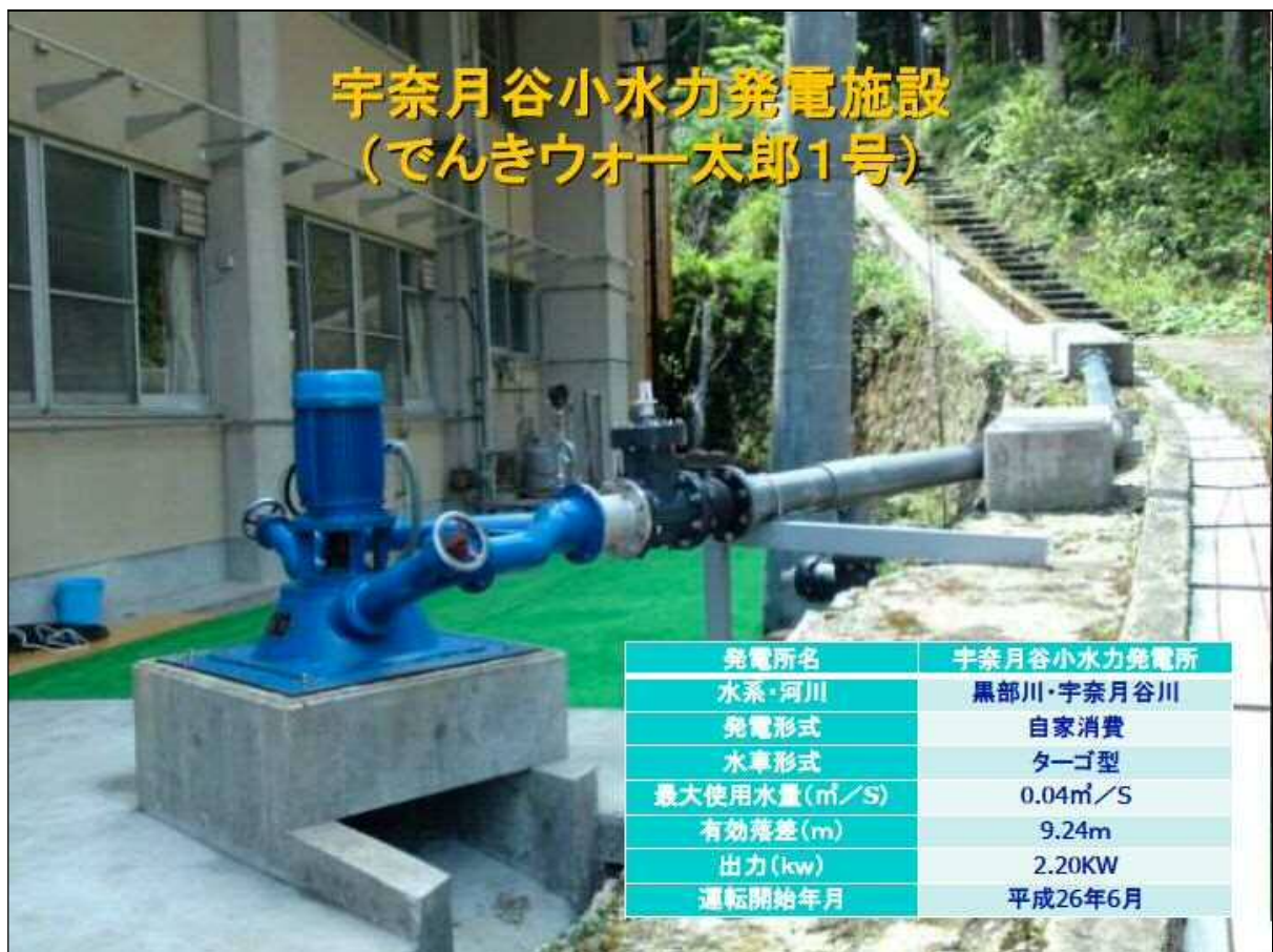
資料4 宇奈月谷小水力発電施設 でんきウオー太郎1号(でんき宇奈月プロジェクト資料)
