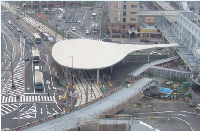
●熊本駅東口駅前広場 真夏の太陽と降り注ぐ雨を遮りながら爽やかな風が吹き抜けるぽかんと浮いた雲の下の公園にいるような空間が出現しました。設計者は今年建築界のノーベル賞と言われているプリツカー賞を受賞した西沢立衛氏。
